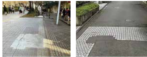
▲タイルの補修も景観への配慮が必要
