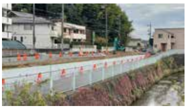
工事が進む新設交差点付近(現況)
